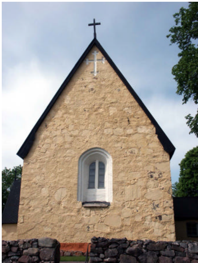
Kyrkans östra gavel har bevarat ett ursprungligt tvådelat fönster. Stenmurens struktur är synlig genom putsen.
